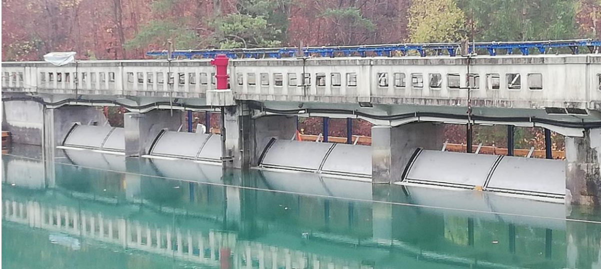
Slika 3: Jeklena zaklopka z gumijasto podporo [1].
