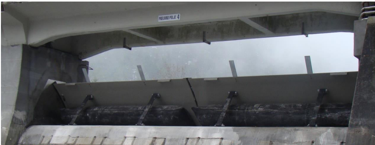
Slika 4: Jeklena zaklopka z gumijasto podporo z dolvodne strani [1].
