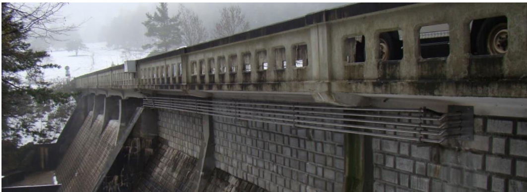
Slika 6: Zračni tlačni cevovodi speljani na dolvodni strani pregrade [1].
