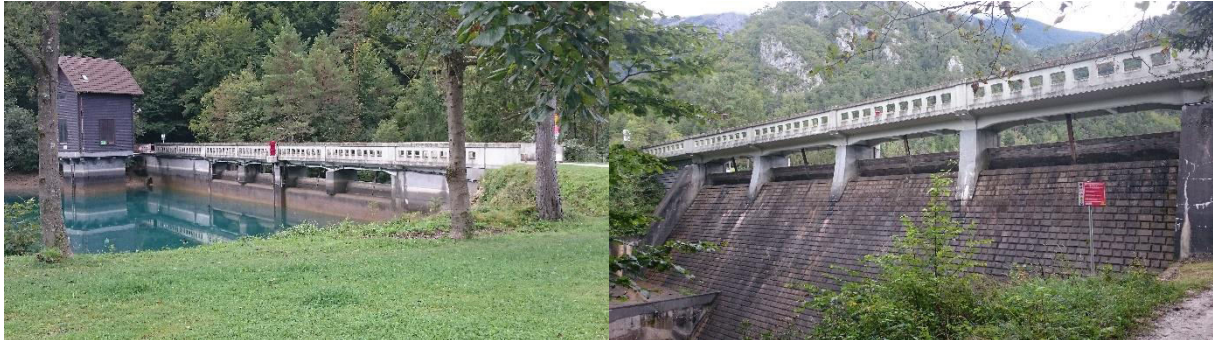
Slika 1: Pregrada Završnica - obstoječi leseni provizorij [1].
